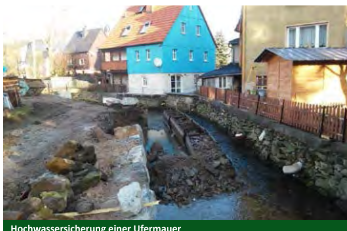
Hochwassersicherung einer Ufermauer
