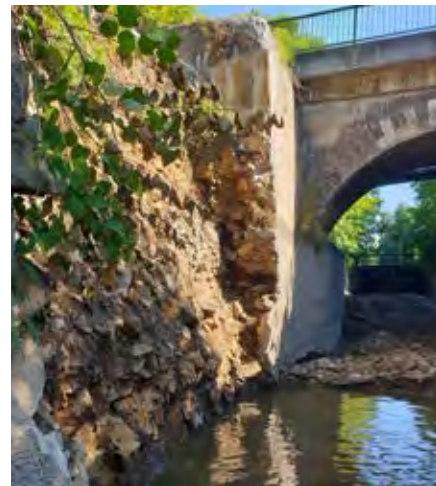
Entleerter Betriebsgraben einer Wasserkraftanlage
